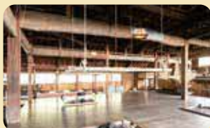
広い板敷きの居間。漁期には200人ものヤン衆が寝泊まりし、立ったまま食事をしたという。
