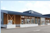
羽幌フェリーターミナル
