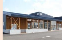
羽幌フェリーターミナル
